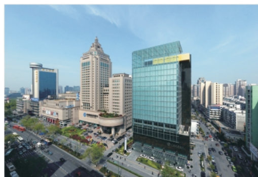
综合整治后的延安路商业街
